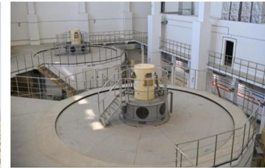
БЕЛОПОРОЖСКАЯ ГЭС-1 И БЕЛОПОРОЖСКАЯ ГЭС-2 Строительство
