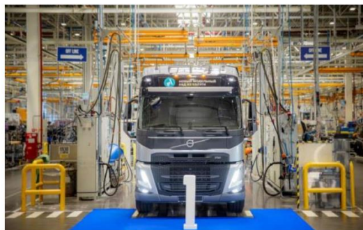
ЗАВОД ПО ПРОИЗВОДСТВУ СТРОИТЕЛЬНОЙ ТЕХНИКИ VOLVO Монтаж технологического оборудования
