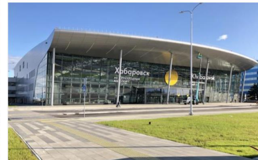
МЕЖДУНАРОДНЫЙ АЭРОПОРТ ХАБАРОВСК Строительство аэропорта
