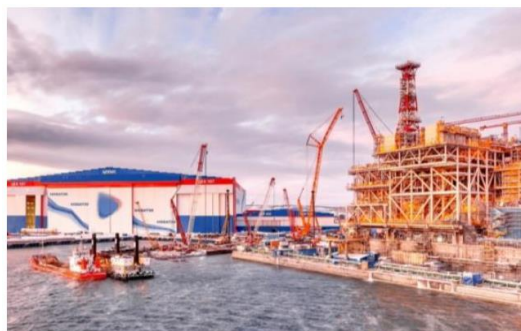
ЦЕНТР СТРОИТЕЛЬСТВА КРУПНОГАБАРИТНЫХ МОРСКИХ СООРУЖЕНИЙ (ПАО «НОВАТЭК») Строительство завода
