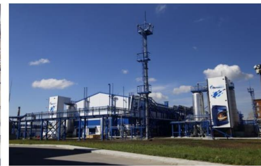
МОСКОВСКИЙ ЗАВОД СМАЗОЧНЫХ МАТЕРИАЛОВ ПАО «ГАЗПРОМНЕФТЬ» Строительство 2-й и 3-й очередей завода
