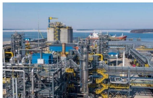
ТЕРМИНАЛ ПО ПРОИЗВОДСТВУ И ПЕРЕГРУЗКЕ СЖИЖЕННОГО ПРИРОДНОГО ГАЗА В ПОРТУ ВЫСОЦК (НОВАТЭК) Строительство завода
