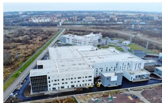
ФАРМАЦЕВТИЧЕСКИЙ ЗАВОД «САМСОН-МЕД» Строительство новой производственной площадки
