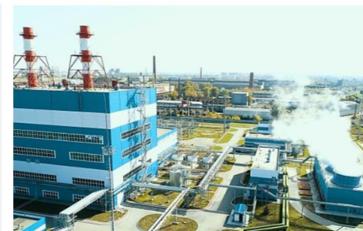
ДЯГИЛЕВСКАЯ ТЭЦ Модернизация (возведение нового энергоблока)
