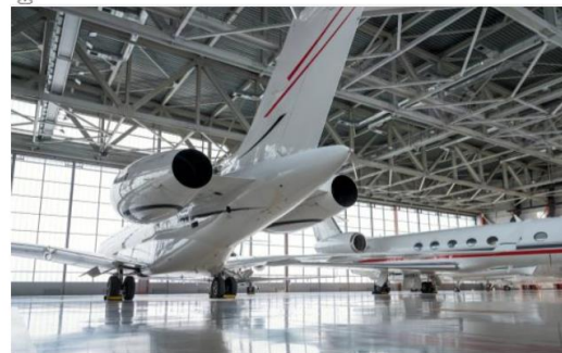
АНГАРЫ ДЛЯ ТЕХНИЧЕСКОГО ОБСЛУЖИВАНИЯ И ХРАНЕНИЯ ВОЗДУШНЫХ СУДОВ В АЭРОПОРТУ ПУЛКОВО Реконструкция
