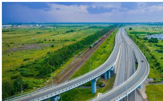
ПЛАТНАЯ АВТОМОБИЛЬНАЯ ДОРОГА М-11 МОСКВА – САНКТ-ПЕТЕРБУРГ Строительство на 15-58 км
