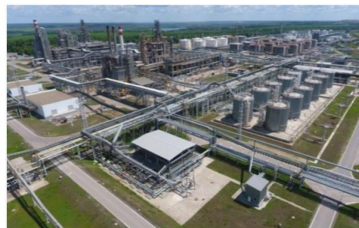
НОВОШАХТИНСКИЙ НЕФТЕПЕРЕРАБАТЫВАЮЩИЙ ЗАВОД Строительство
