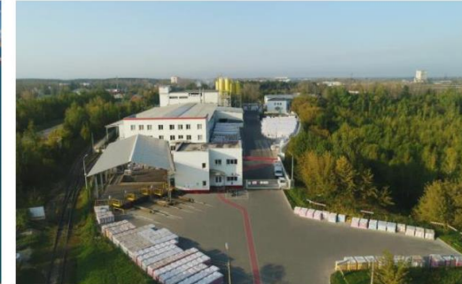
ЗАВОД ПО ПРОИЗВОДСТВУ ОТДЕЛОЧНЫХ СТРОИТЕЛЬНЫХ СМЕСЕЙ LAB INDUSTRIES Строительство завода
