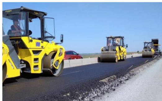
ФЕДЕРАЛЬНАЯ АВТОМОБИЛЬНАЯ ДОРОГА Р-254 «ИРТЫШ» Реконструкция
