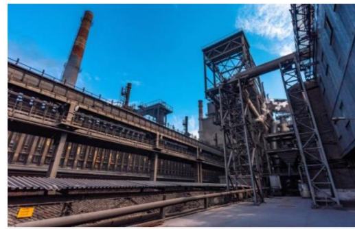
МЕТАЛЛУРГИЧЕСКИЙ КОМБИНАТ «УРАЛЬСКАЯ СТАЛЬ» Возведение производственного комплекса 6-й коксовой батареи
