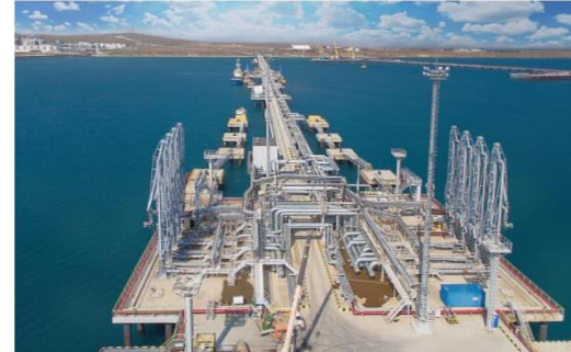
ТЕРМИНАЛ ПО ПЕРЕВАЛКЕ АММИАКА И КАРБАМИДА ПАО «ТОЛЬЯТТИАЗОТ» Техническое перевооружение объектов перевалочного комплекса
