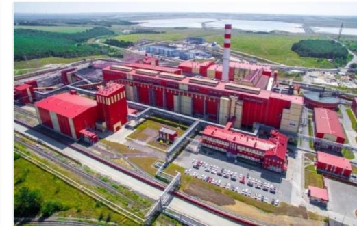
СТОЙЛЕНСКИЙ ГОРНО-ОБОГАТИТЕЛЬНЫЙ КОМБИНАТ ГРУППЫ НЛМК Реконструкцию корпуса обогащения и новое строительство секции дообогащения
