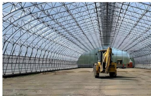
ЛЕСНОЙ СЕЛЕКЦИОННО-СЕМЕНОВОДЧЕСКИЙ ЦЕНТР SEGEZHA GROUP Завершение строительства лесосеменного комплекса
