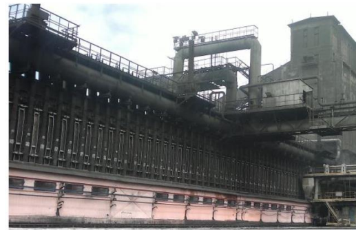
ЧЕЛЯБИНСКИЙ ЗАВОД ПО ПРОИЗВОДСТВУ КОКСОХИМИЧЕСКОЙ ПРОДУКЦИИ Реконструкция коксовых батарей № 4, 5, 6
