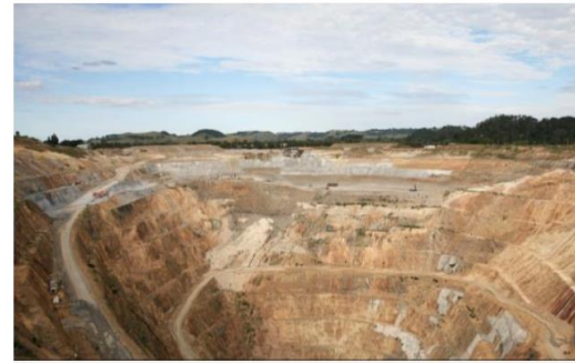
ГОРНО-ОБОГАТИТЕЛЬНЫЙ КОМБИНАТ НА ЗОЛОТОСЕРЕБРЯНОМ МЕСТОРОЖДЕНИИ КУМРОЧ НА КАМЧАТКЕ Строительство комбината
