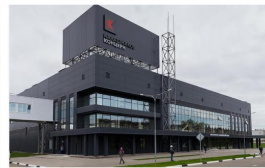
КОНСТРУКТОРСКО-ТЕХНОЛОГИЧЕСКИЙ ЦЕНТР АО «КОНЦЕРН КАЛАШНИКОВ» Строительство здания центра
