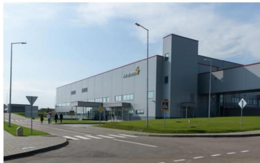
ФАРМАЦЕВТИЧЕСКИЙ ЗАВОД ASTRAZENEKA Строительство завода
