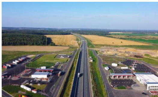
СКОРОСТНАЯ АВТОМОБИЛЬНАЯ ДОРОГА М-12 МОСКВА – КАЗАНЬ 4 этап строительства
