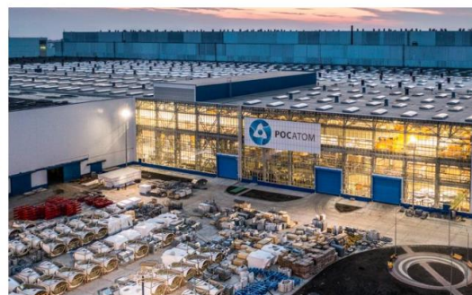
ЗАВОД ПО ПРОИЗВОДСТВУ ВЕТРОУСТАНОВОК АО «НОВАВИНД» Техническое перевооружение корпуса и кранового хозяйства одного из цехов
