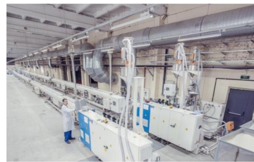
ЗАВОД ПО ПРОИЗВОДСТВУ ПОЛИПРОПИЛЕНОВЫХ ТРУБ Строительство
