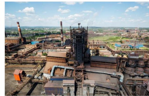
НИЖНЕТАГИЛЬСКИЙ МЕТАЛЛУРГИЧЕСКИЙ КОМБИНАТ (ПАО «ЕВРАЗ») Реконструкция коксовых батарей № 5, 6
