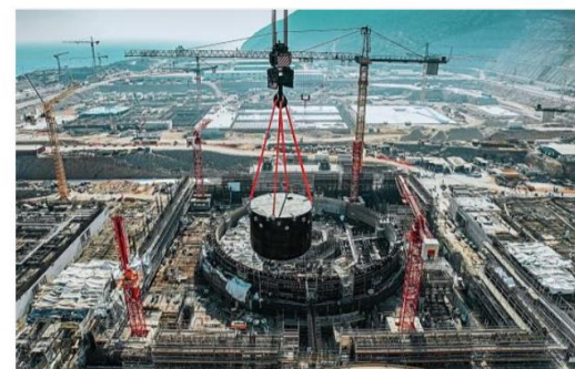
АТОМНАЯ ЭЛЕКТРОСТАНЦИЯ «АККУЮ» Строительство
