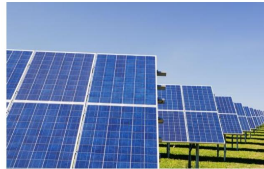
СОЛНЕЧНЫЕ ЭЛЕКТРОСТАНЦИИ «ВЕРШИНА ДЕВЕЛОПМЕНТ» Строительство
