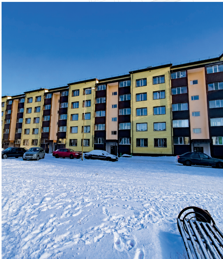
«Капитальный ремонт жилых домов» г. Темиртау
