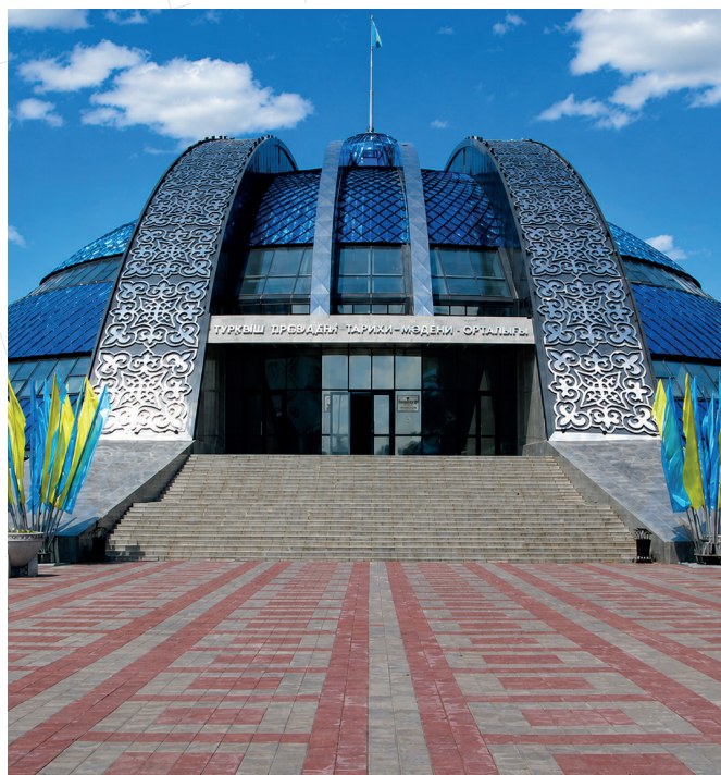
«Капитальный ремонт КГКП «Историко-культурный центр Первого президента» г. Темиртау»
