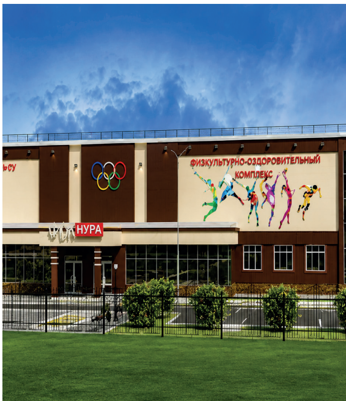
«Строительство физкультурно-оздоровительного комплекса на 160 мест» Карагандинская область, поселок Киевка
