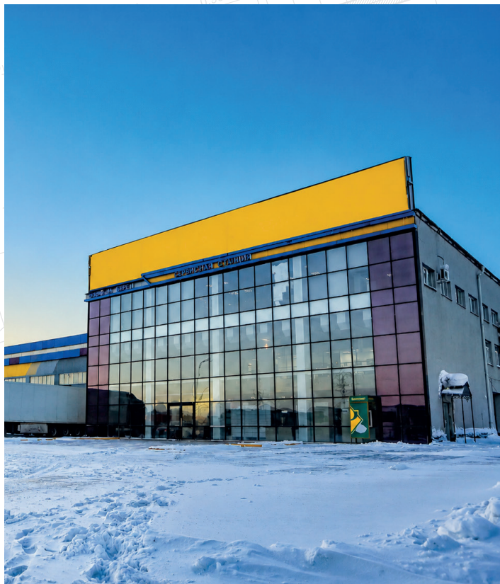
«Строительство торгово-сервисного центра «Вольво Центр» г. Темиртау
