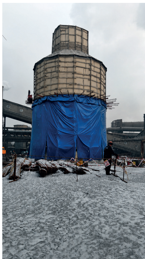
«Строительство дымовой трубы Н=150м, ТЭЦ-ПВС» АО «АрселорМиттал Темиртау»
