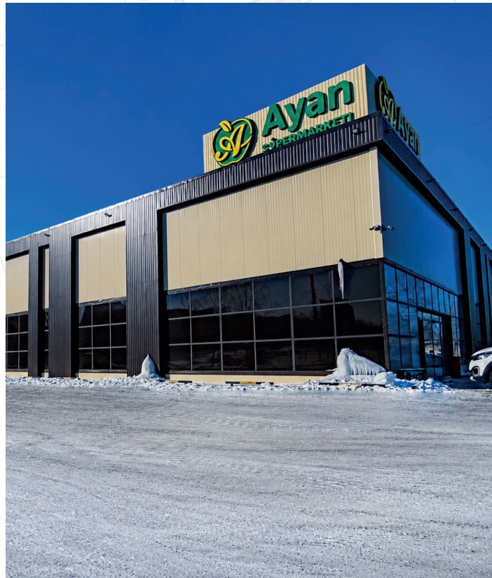
«Строительство сети компаний супермаркетов «Аян» г. Темиртау
