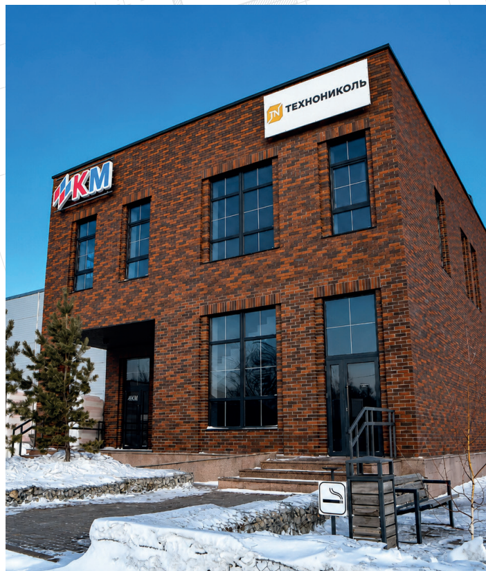
«Строительство офисного здания со складскими помещениями» г. Темиртау
