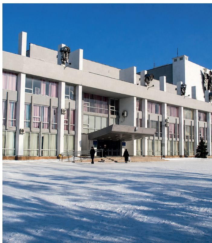
«Капитальный ремонт КГКП «Темиртауский Дворец Культуры» г. Темиртау
