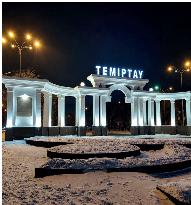
«Строительство ротонды по пр. Metallургов» г. Темиртау
