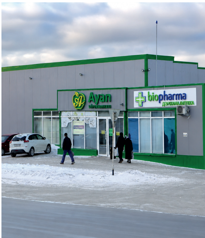
«Строительство сети компаний супермаркетов «Аян» г. Темиртау
