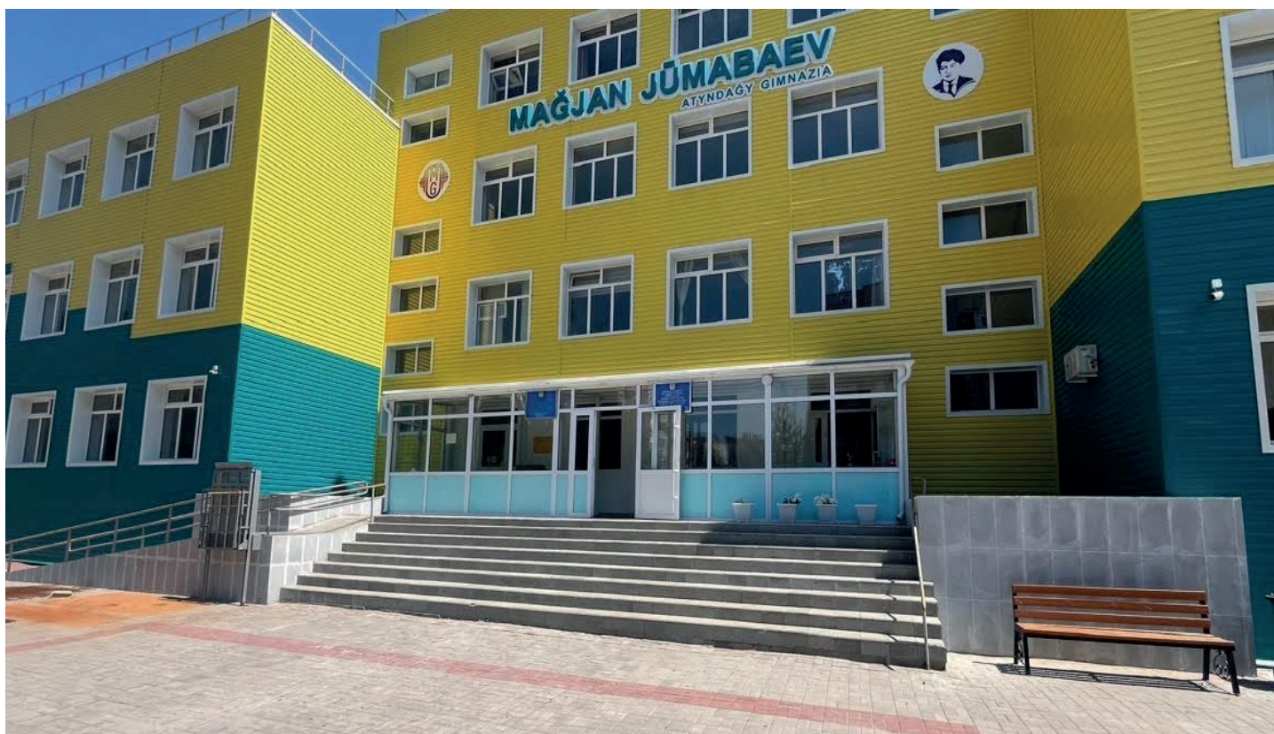
«Капитальный ремонт здания КГУ «Гимназия имени Магжана Жумабаева» Карагандинская область, г. Караганда, район им. Казыбек Би, Степной 4-й микрорайон, строение 33/2»
