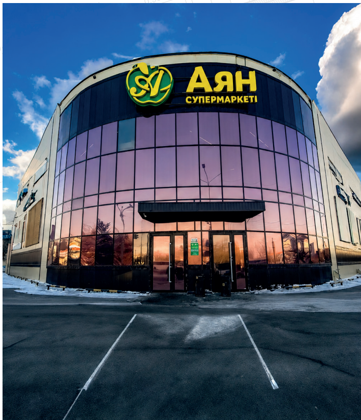
«Строительство сети компаний супермаркетов «Аян» г. Темиртау
